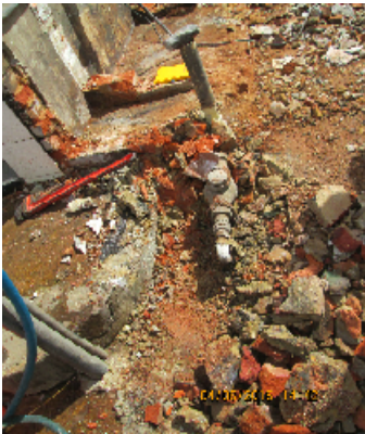
Foto No. 3. Vista del sitio donde se localizaba el medidor.
